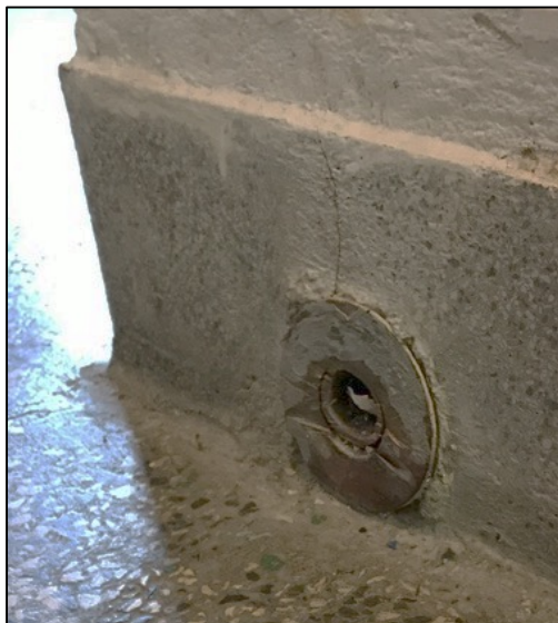
Odstranit staré kotvení c teracovém soklu
